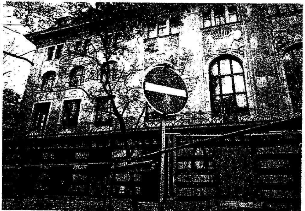
Die Sanierung der Zentrale der Industrie- und Handelskammer erweist sich als problematisches Projekt, das sich immer weiter verzögert.
